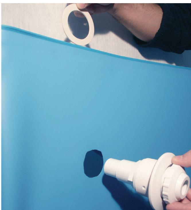
*Stecken Sie nun eine Dichtung auf die Düse und schieben die Düse von innen durch das Loch nach aussen.*
