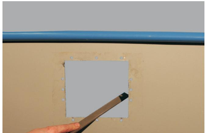
Entgraten Sie das Blech mit einer Feile so, dass keine scharfen Kanten mehr vorhanden sind.
