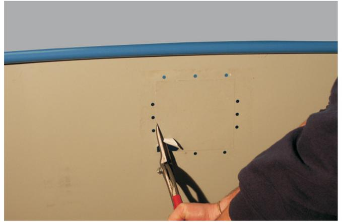
Schneiden Sie die Öffnung für den Skimmer mit einer Blechschere aus.
