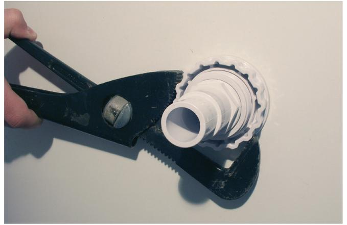
*Jetzt können Sie die Kontermutter gefühlvoll mit einer Zange festziehen.*
