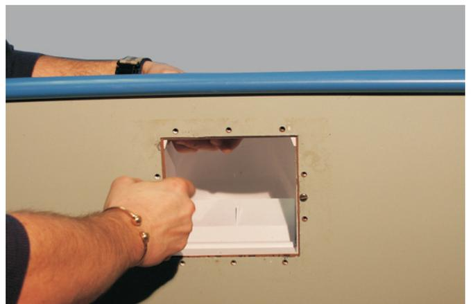
Schrauben Sie den Skimmer rechts und links mit zwei der mitgelieferten Schrauben fest an der Stahlwand an.
